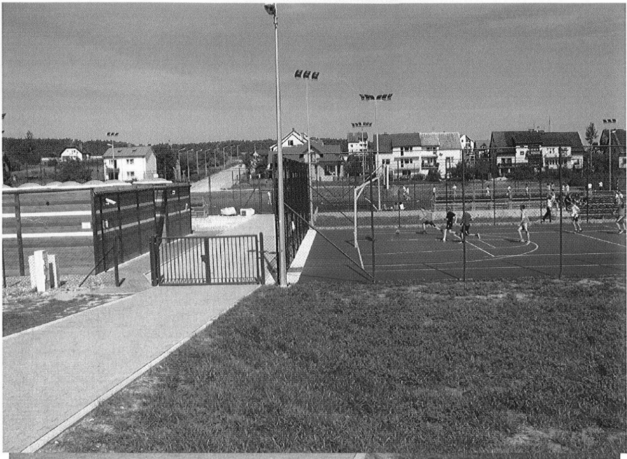
Zdj.1 Wejście na teren boisk sportowych. W tle pomieszczenia socjalne - kontenery szatniowo – sanitarne.
