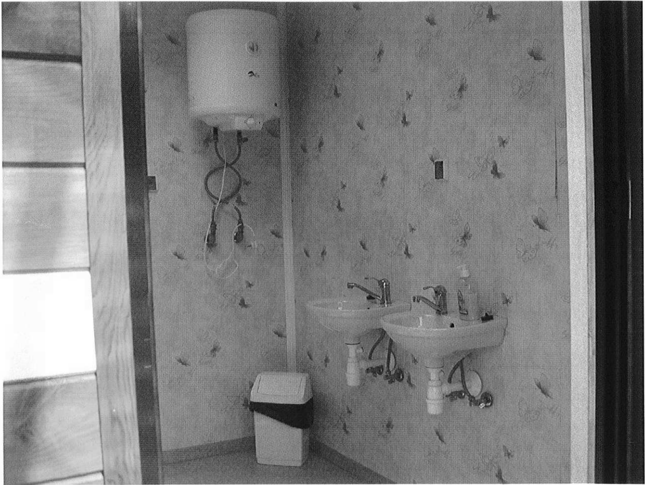
Zdj.6 Kontenery - Wnętrze pomieszczenia szatniowo-sanitarnego
